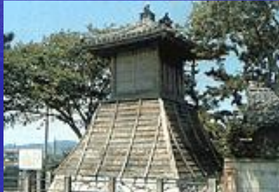
Farol de Maeshiba – Japão segundo mais antigo do Japão construído em madeira
