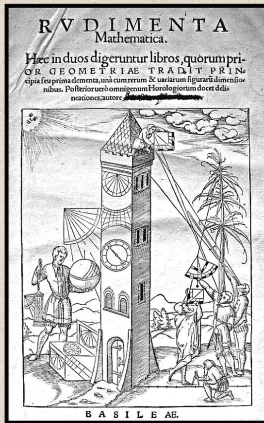
*Fig. 3. Frontispício de Rudimenta Mathematica de Sebastião Münster (Basileia, 1559), onde se representam vários instrumentos usados em operações de altimetria, nomeadamente o quadrante, o quadrado geométrico e o báculo de Jacob, sendo este utilizado pelo homem figurado mais à direita.*
