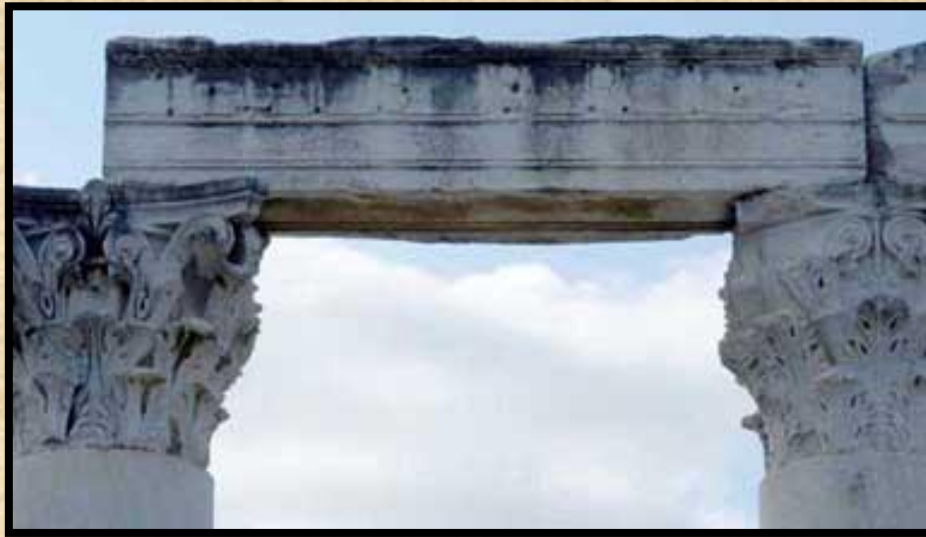
Sistema trabeated de construção grega
