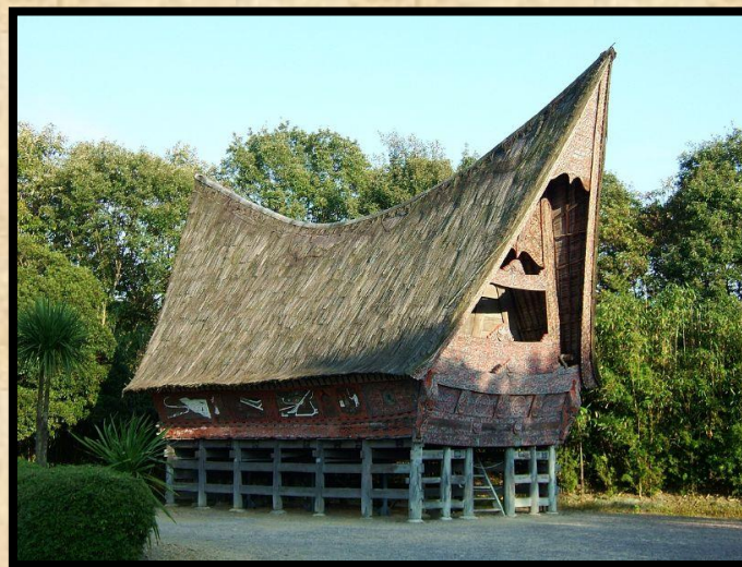
Habitações tradicionais sobre estacas - Indonésia
