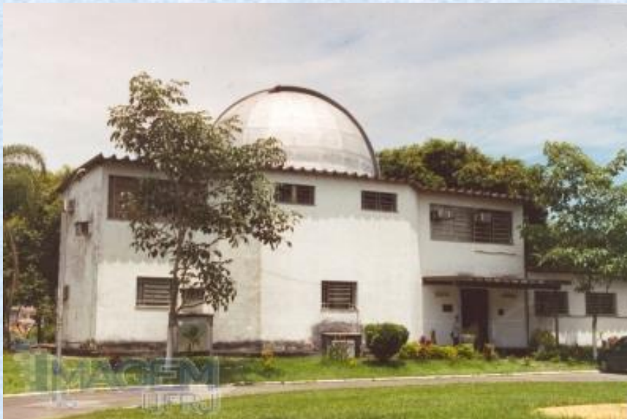
*Observatório do Valongo-UFRJ*
