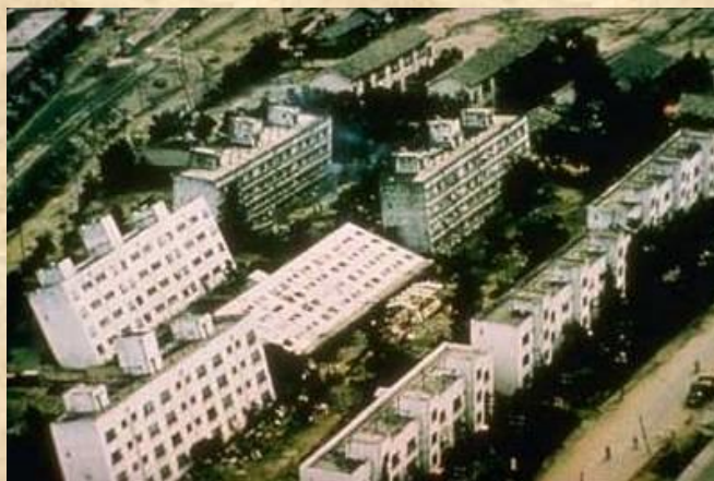
*Estragos causados por um terremoto de magnitude de 7,4 que atingiu Niigata no Japão, em 1964*
