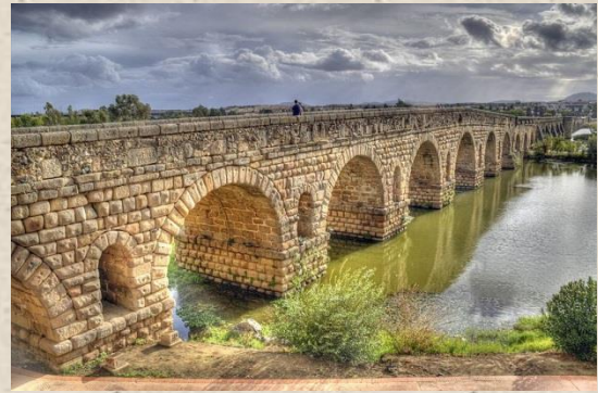
Ponte de Mérida, Espanha
