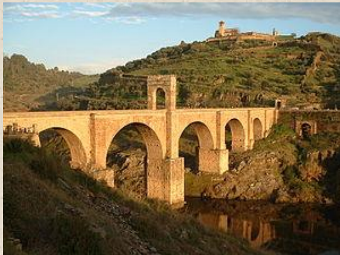
A Ponte de Alcântara, na Espanha, obra-prima da construção romana.
