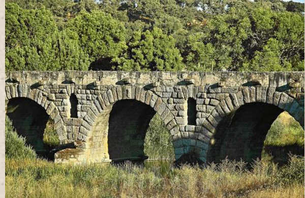
Ponte de Vila Formosa, Portugal
