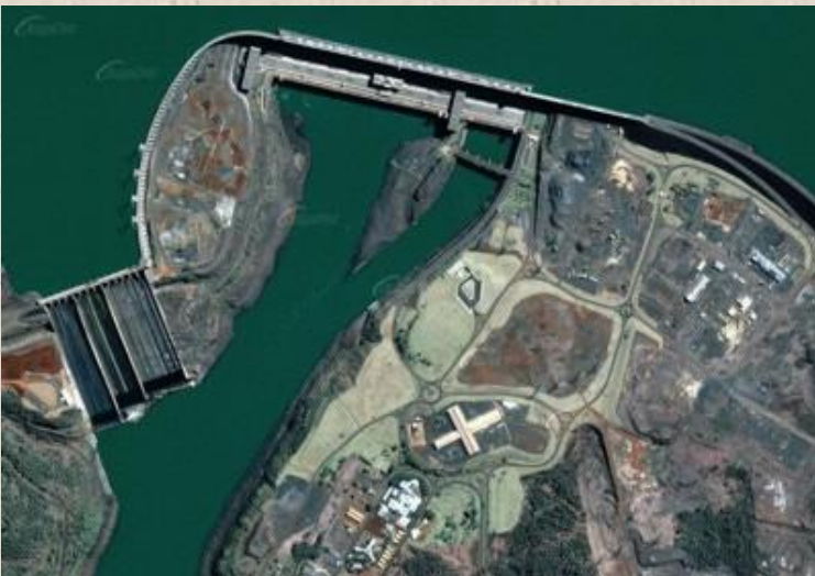
Hidrelétrica de Itaipu.
