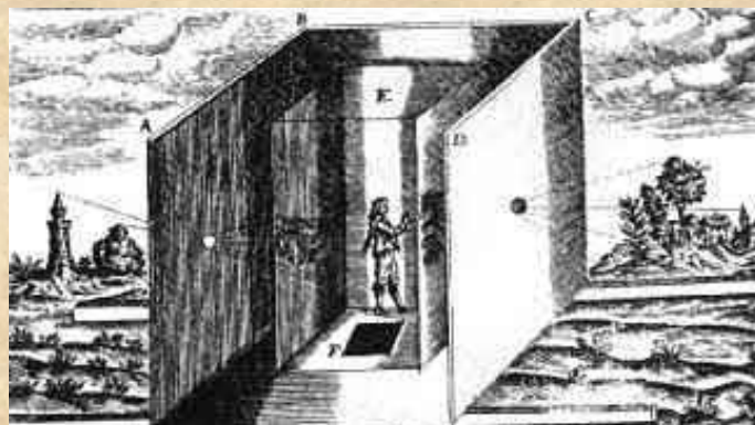
*Câmera Escura em forma de liteira, construída em 1646 por Athanasius Kircher*
