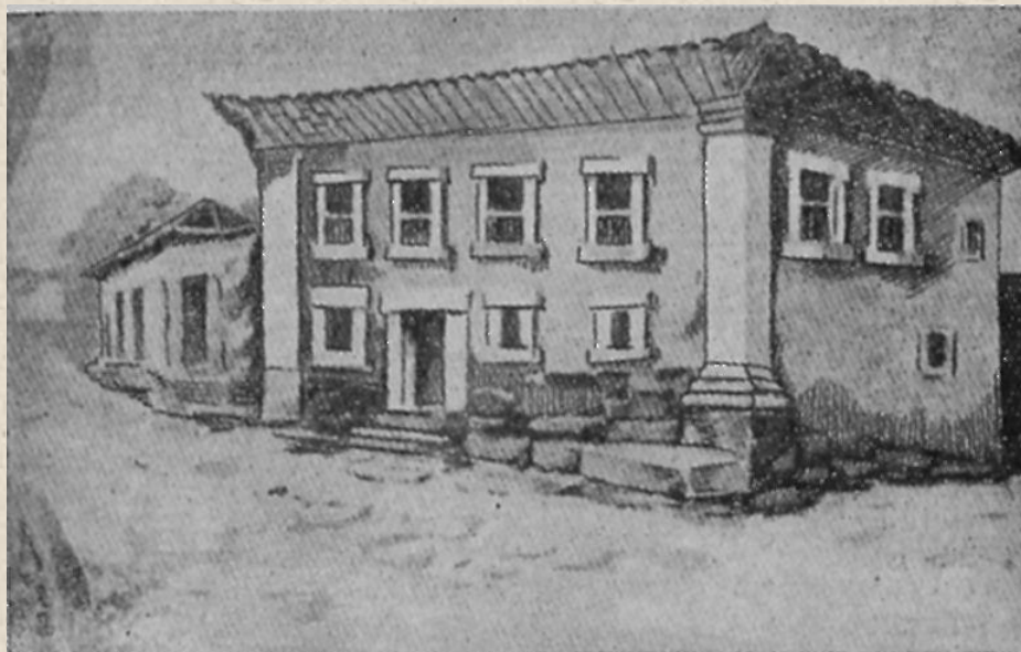
Casa Forte – São João Del Rei
