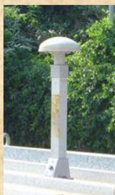
Antena de telhado para GPS
