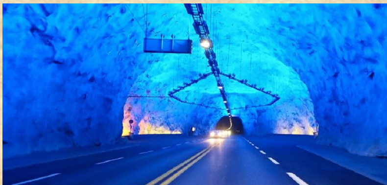
Iluminação interna no túnel de Laerdal.
