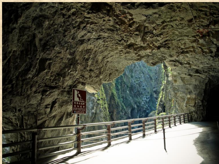
Túnel de Jiucyudong
