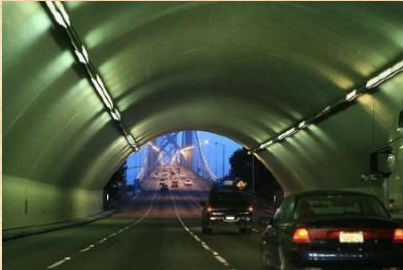
Túnel de Yerba Buena.
