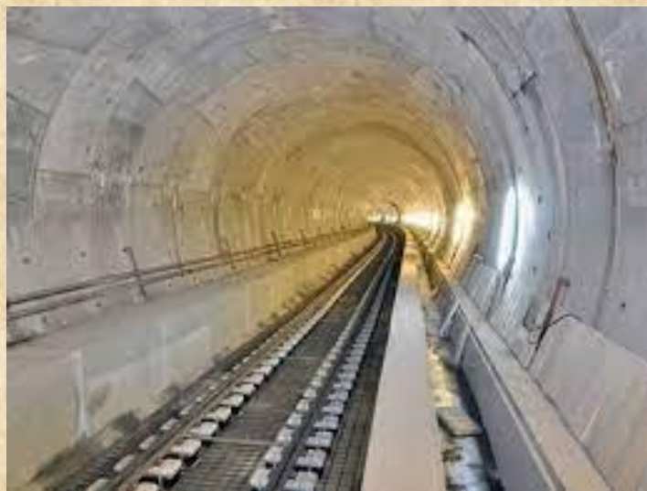
Túnel de Marmaray sobre o estreito de Bósforo. (fonte: https://www.azernews.az/media/pictures/railway_tunnel_220213.jpg )
