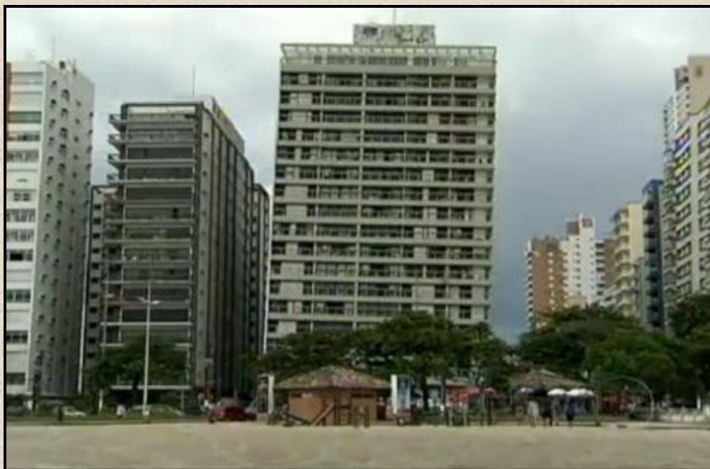
Prédio com deslocamento vertical
