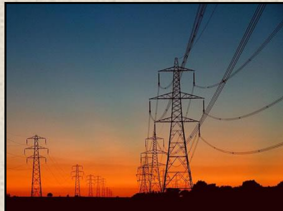
Linhas de alta tensão
