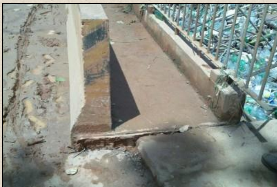
Deslocamento em cabeceira de ponte
