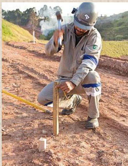
Figura 14. Piquete e estaca. Fonte: Obra SUDECAP (2011).
