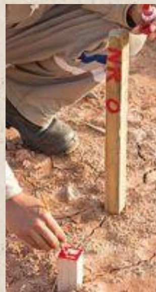
Figura 14. Piquete e estaca. Fonte: Obra SUDECAP (2011).
