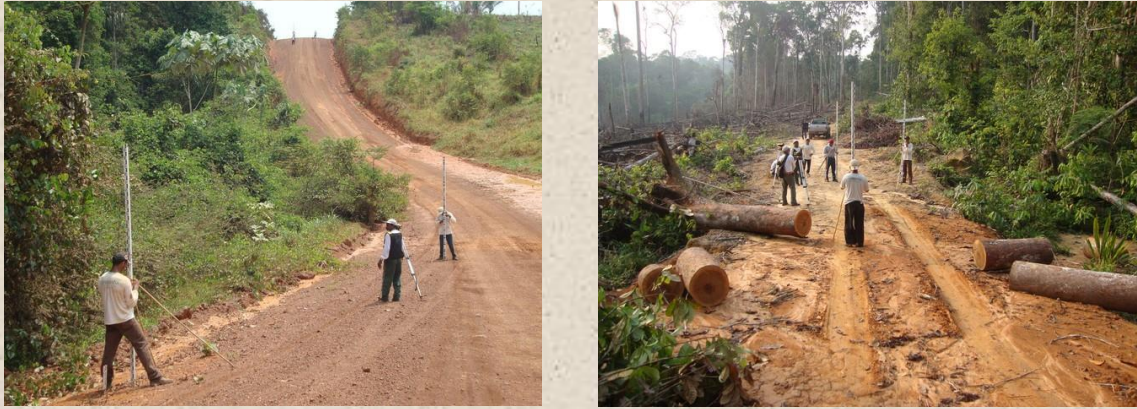
Figura 18. Nivelamento de estrada
